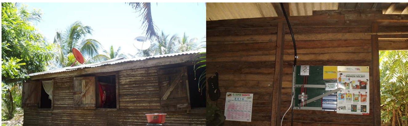
Figura 1 - Imagen de un sistema solar de uso doméstico instalado en la casa de un cliente. (fuente: ODEF)
