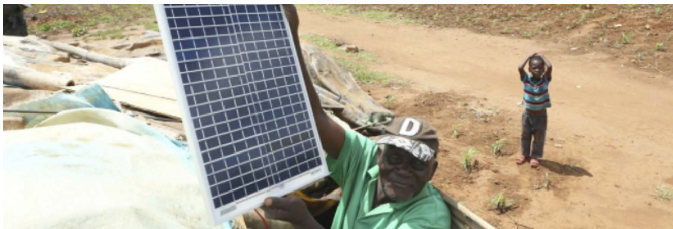
Figura 2 - Panel solar en una zona zimbabuense fuera de la red eléctrica. (fuente AP Photo/Tsvangirayi Mukwazhi)
